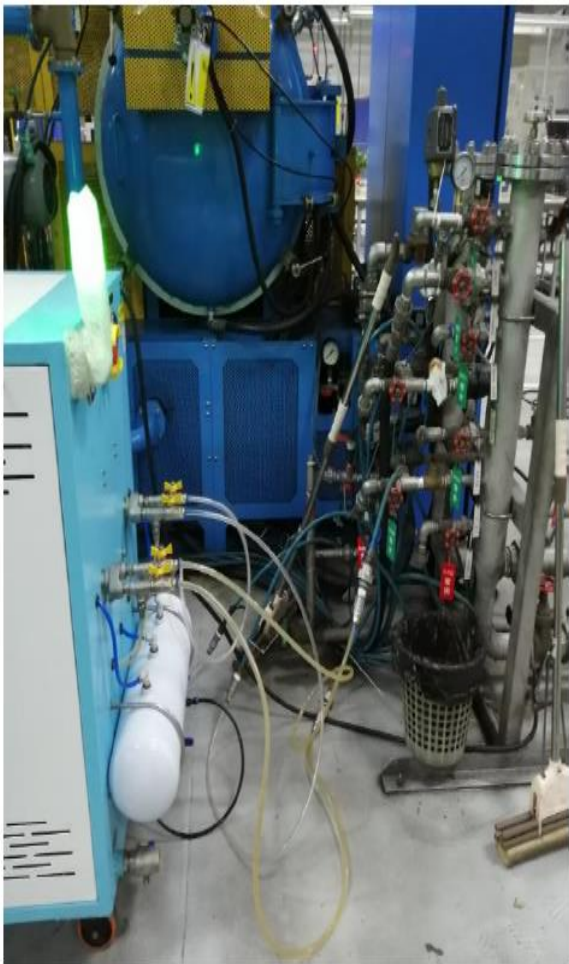
真空炉冷却水路清洗
