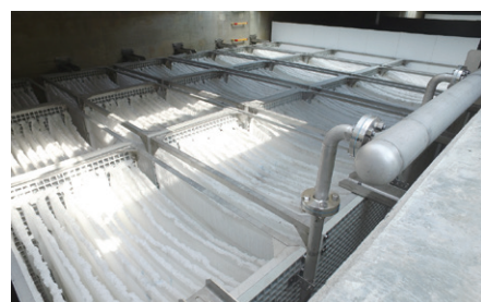
填料安装事例照片
